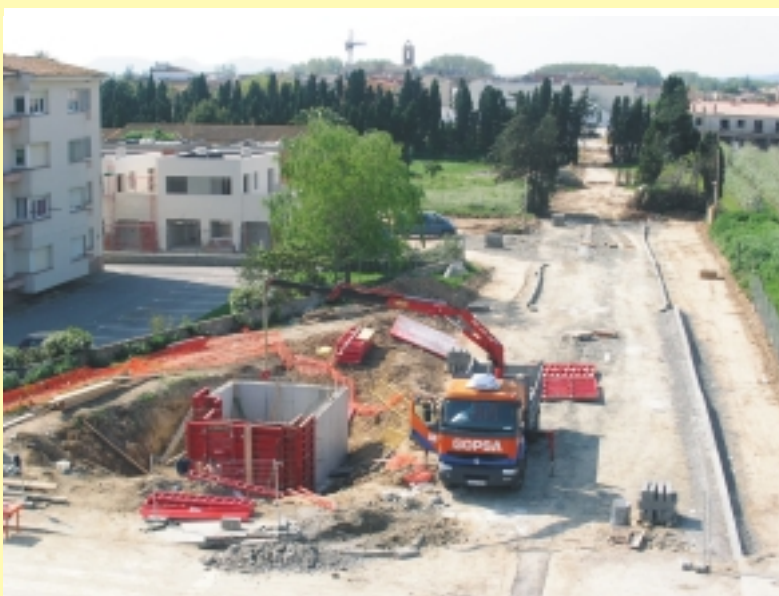
Estat de les obres d'urbanització del Carrer A
