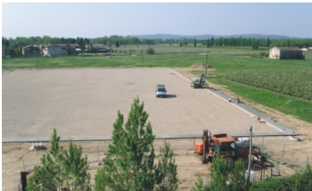
Les obres de construcció del camp d'esports
